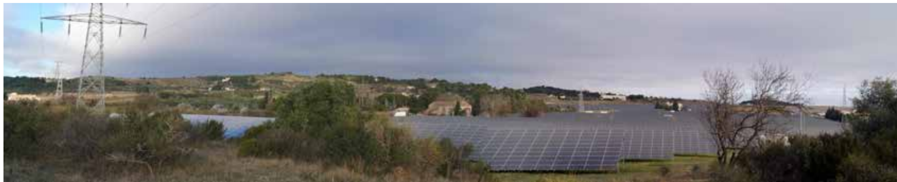
Présentation générale de l'installation
