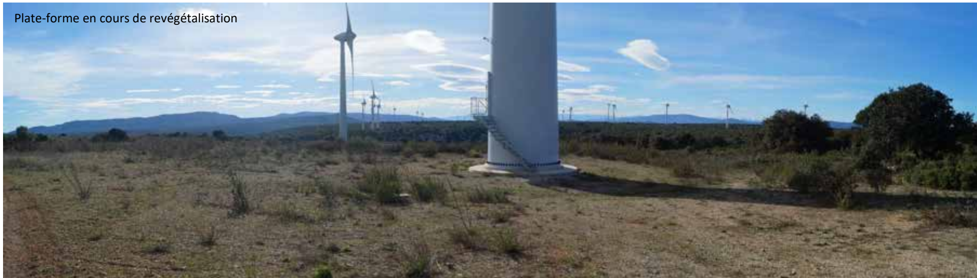
Plate-forme correctement remblayée, avec une reprise de la végétation difficile
