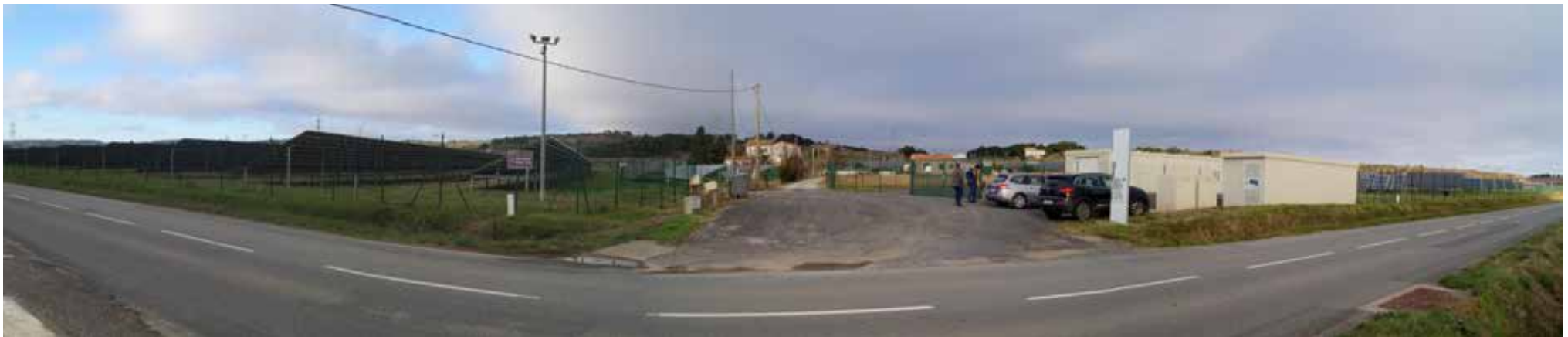
Vue générale des installations du parc solaire de la Malvezy depuis la RD 6009
