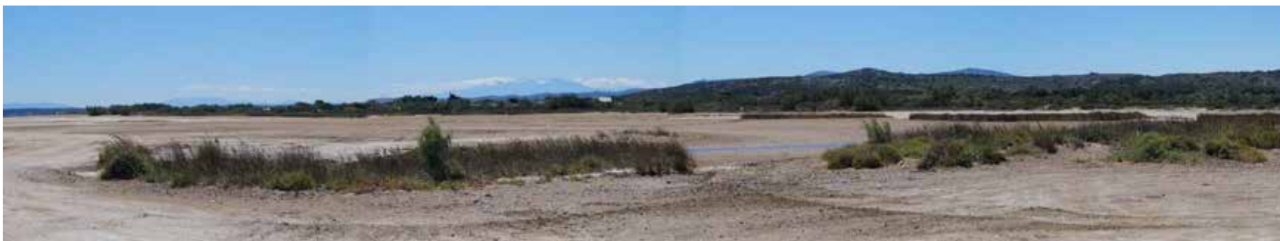
Co-visibilité des parcs éoliens de Fitou, Treilles et Opoul depuis la plage de Port-la-Nouvelle
