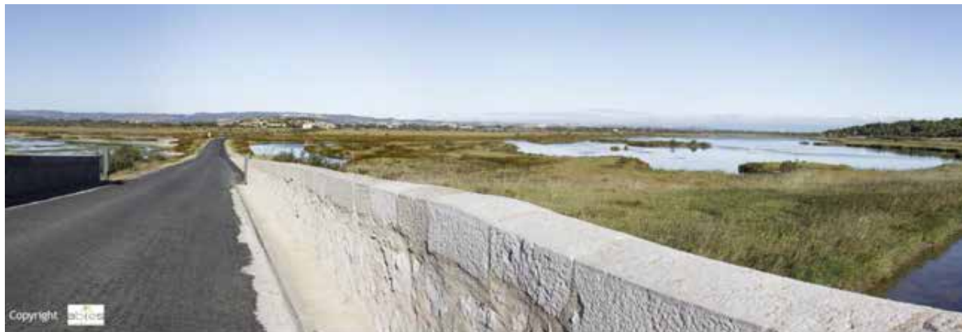
Vue en direction du Canal du Midi et de la Robine depuis le Pont de Mandirac
