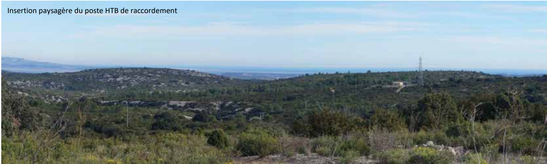
Poste de raccordement
