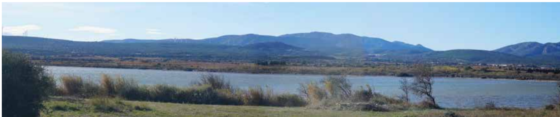
Co-visibilité des parcs éoliens de Fitou, Treilles et Opoul depuis la RD 627 (étang de Leucate)
