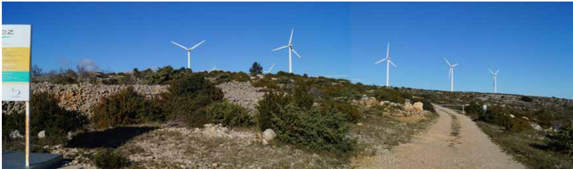
Piste d'accès au parc éolien
