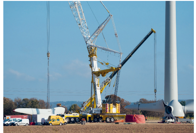
Chantier éolien de Cuxac d'Aude © SA ABIES
