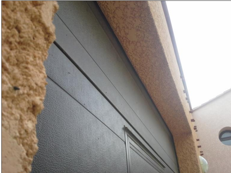
Indices de présence de chiroptères (guano collé à la porte) observés sur le gîte N°6 (carte 1) Pas d'observation d'individus au niveau de la fissure (X. Leal)
