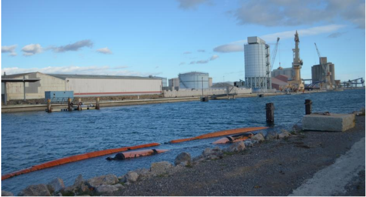
Port industriel de Port-la-Nouvelle. Photo E2D
