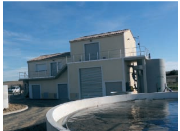
Station d'épuration d'Ouveillan
